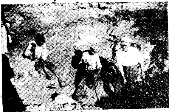
Έργαται σκάπτοντες σέ Μεταλλεία 40-50 μέτρων βάθους.
